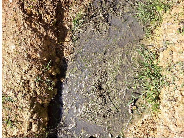
Foto 5: Parte externa do CRRPA – esgoto
